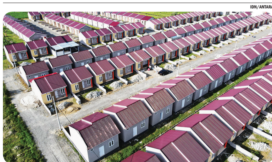
PEMBIAYAAN PERUMAHAN 2023 Foto udara pembangunan perumahan bersubsidi di Kabupaten Sigi, Sulawesi Tengah, Jumat (2/9). Kementerian Pekerjaan Umum dan Perumahan Rakyat (PUPR) mengalokasikan program pembiayaan perumahan pada tahun 2023 dengan total anggaran Rp34,17 triliun untuk 274.924 unit guna mendukung pemilikan rumah bagi masyarakat.
